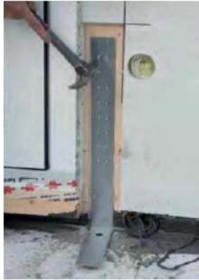
Ankru montaaž (kinnitus vundamenti on veel teostamata)
