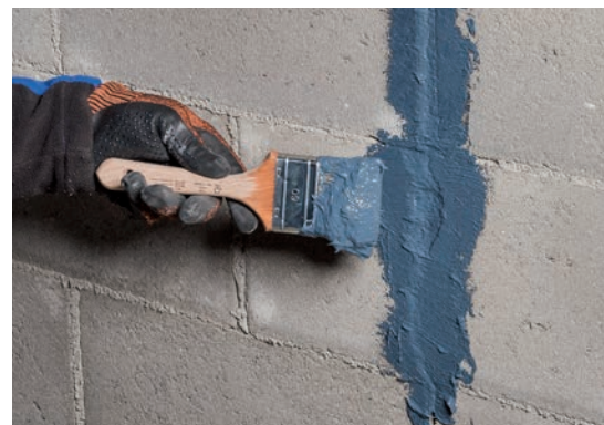
AEROSANA VISCONN FIBRE Pintseldatav pindade ja liitekohtade katkematuks õhupidavaks tihendamiseks ja kuni 20 mm vuukidega liitekohtade tihendamiseks, must, valge
